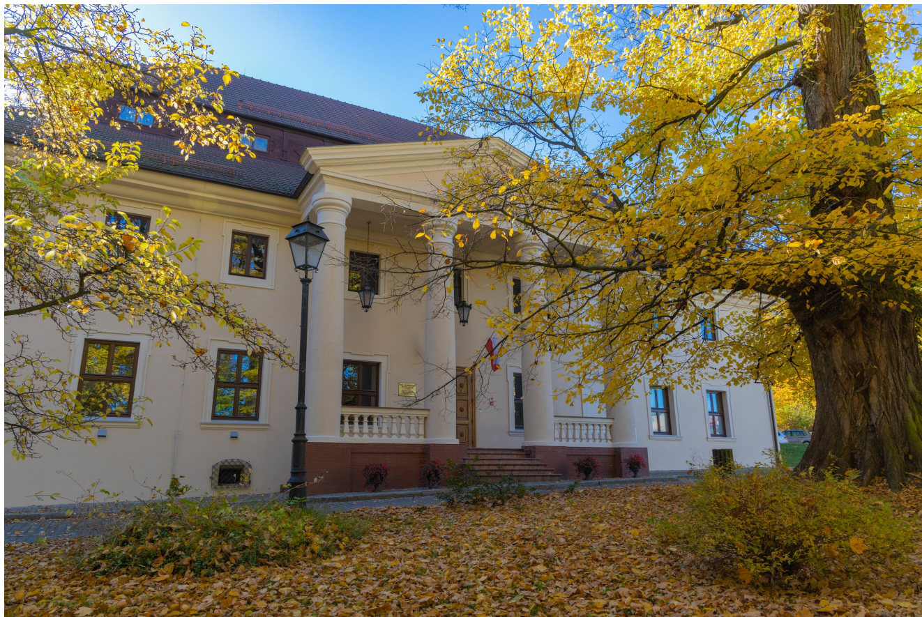
Renowacja/wymiana okien, renowacja elewacji oraz orywnowanie Dworu Zieleniewskich w Trzebini.
