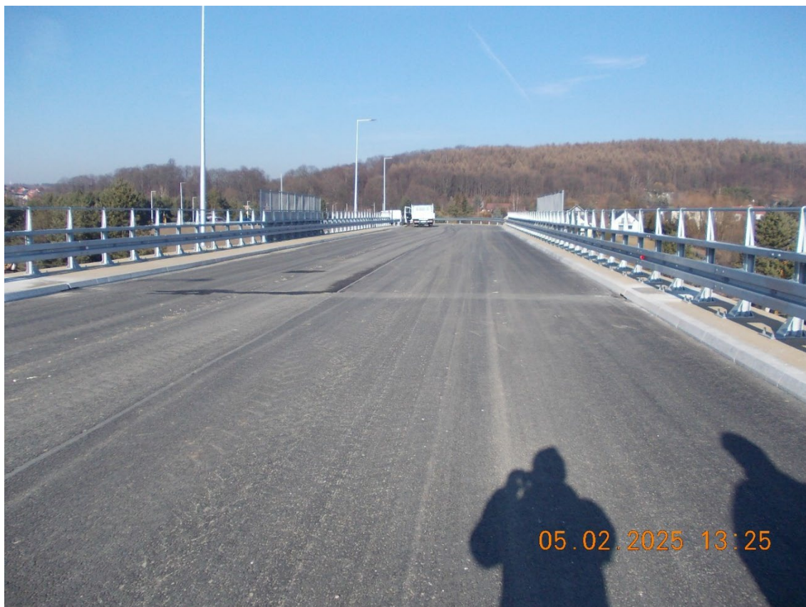
Młoszowa – budowa nowego wiaduktu drogowego nad torami kolejowymi
