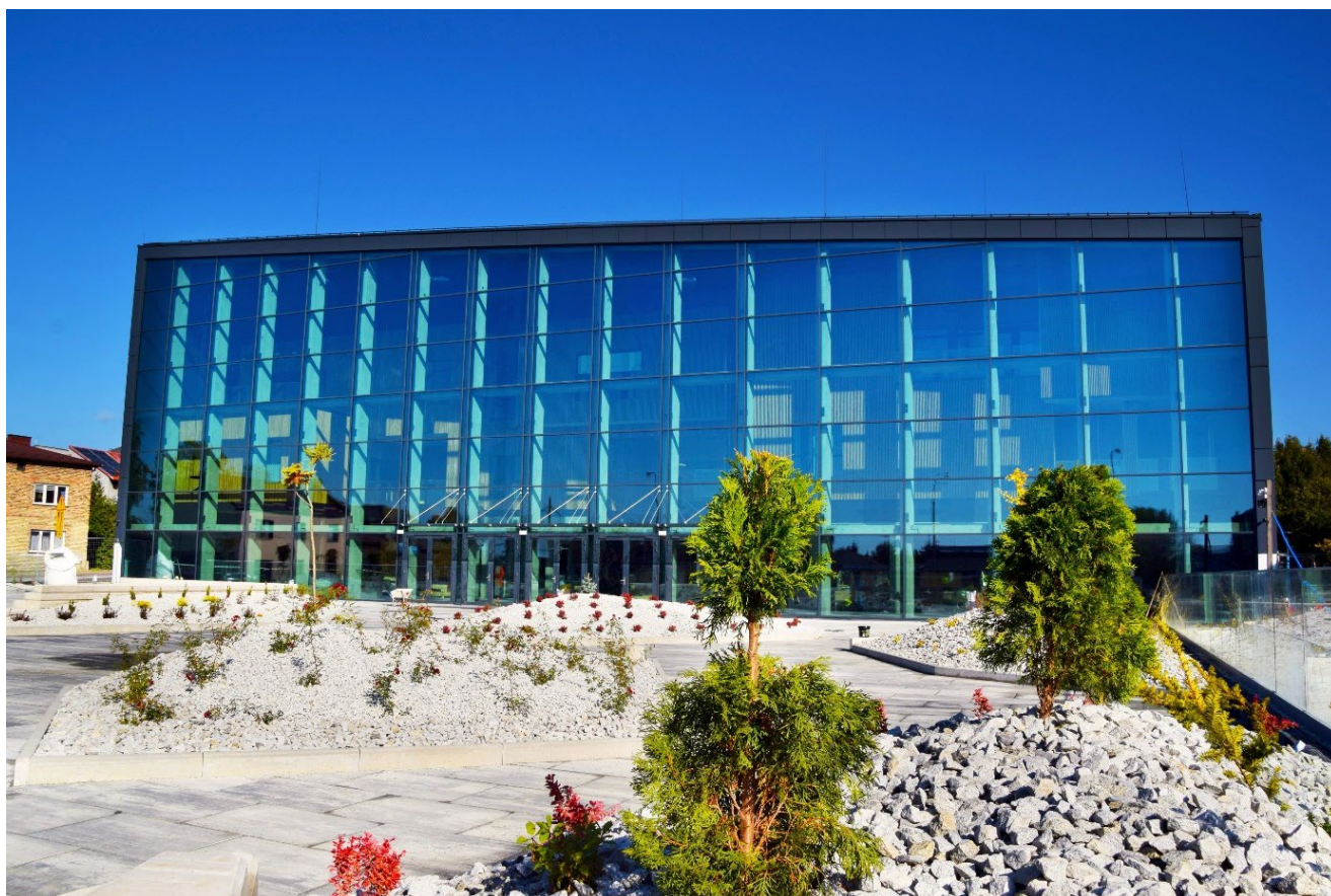
Nowopowstały obiekt przy zbiegu ulic Krakowskiej i Ochronkowej.
