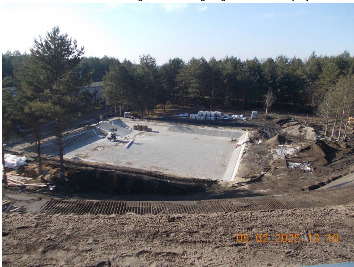
Młoszowa, budowa drogi łączącej ul. Trzecią z ul. Krakowską wraz z wiaduktem nad linią kolejową
