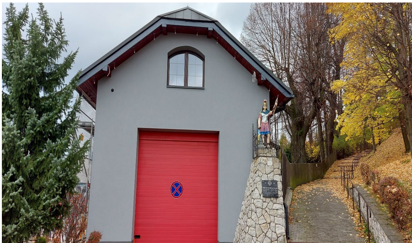
OSP Płoki – obiekt po przebudowie przegrody zewnętrznej
