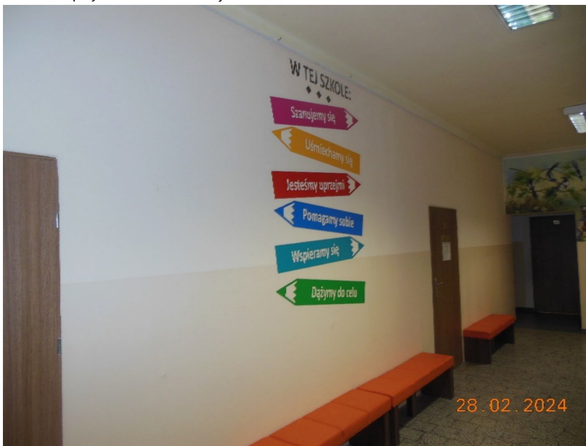
Zespół Szkolno – Przedszkolny w Młoszowej – remont części korytarza na I piętrze.
